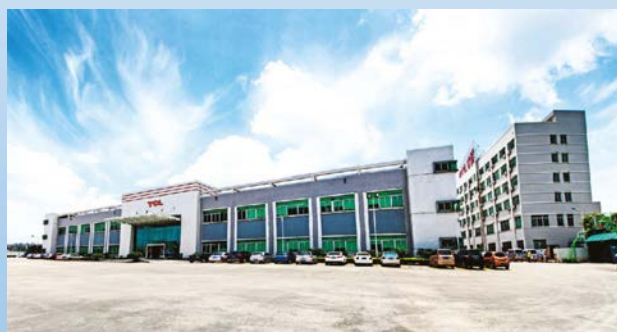
Jiujiang Base (2 εκ. σετ κλιματιστικών)
